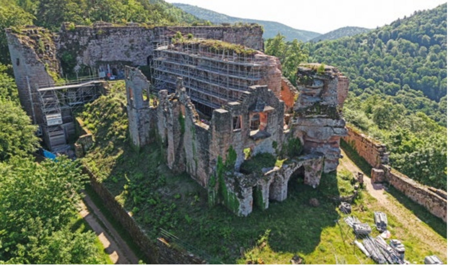
Die Burg Neuscharfeneck ist eingerüstet. Es laufen Arbeiten zum Erhalt und zur Sicherung des Baudenkmals. Bild: Manfred Anker/Burgverein
